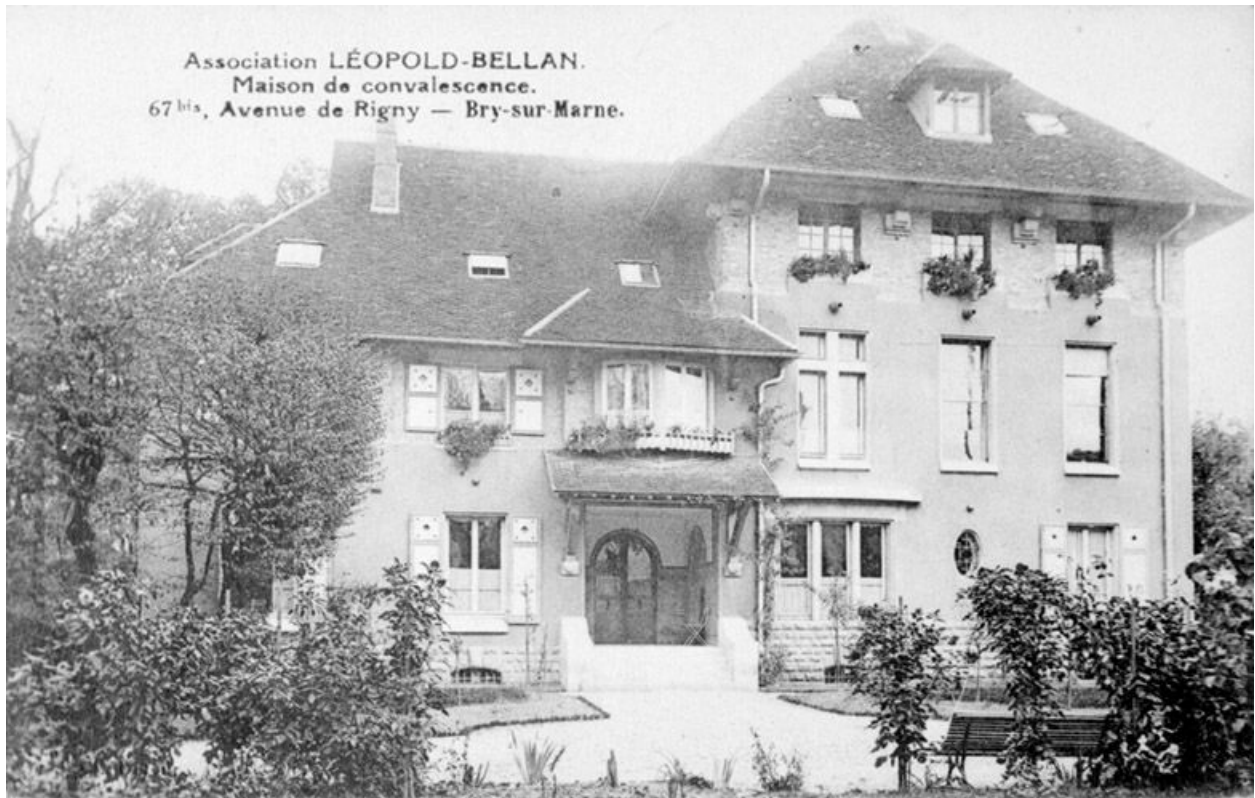
Vue de la maison de convalescence de l'association Léopold-Bellan, construite dans le parc du stade. Carte postale. (Collection particulière)
