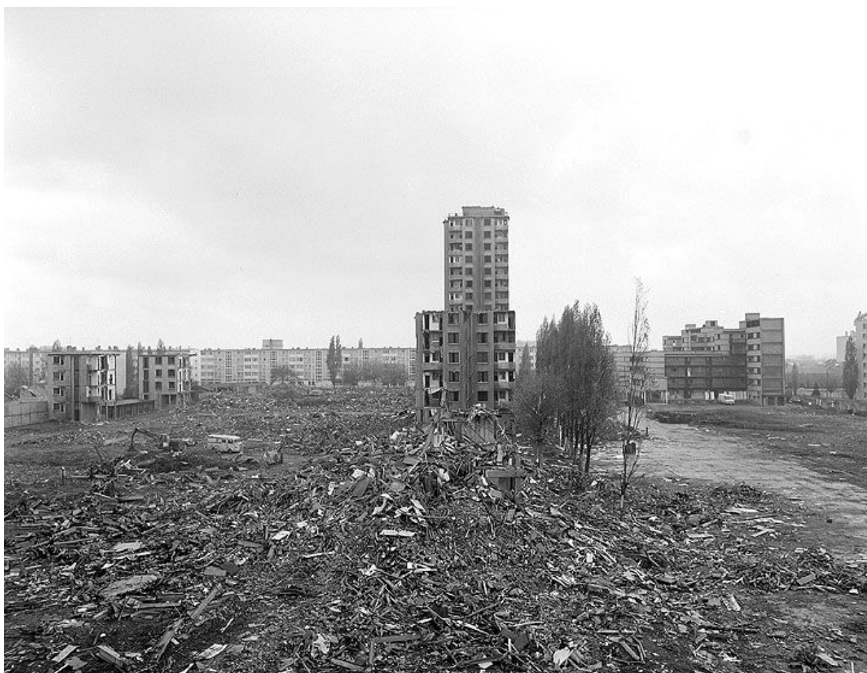
Vue des tours 4, 3 et 2 à partir de la tour 5. Campagne photographique, lors de la destruction du bâtiment en 1976.
