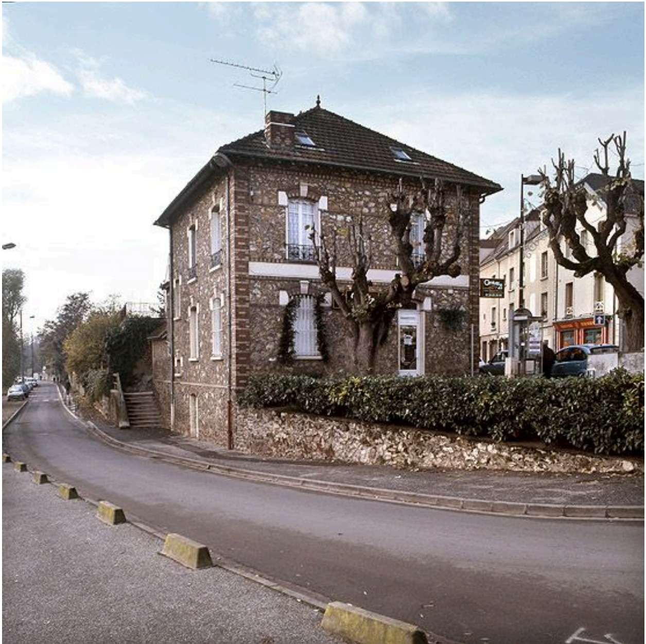
Façade latérale et postérieure.
