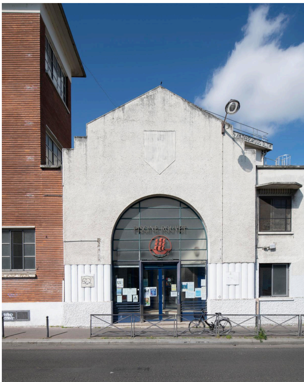
Façade sur la rue de la piscine Rouvet.
