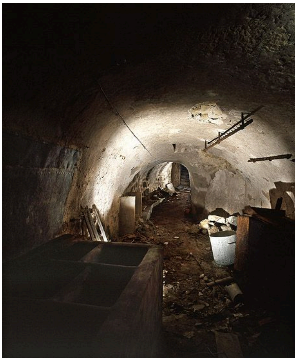
Le cellier, vue en direction de l'entrée.
