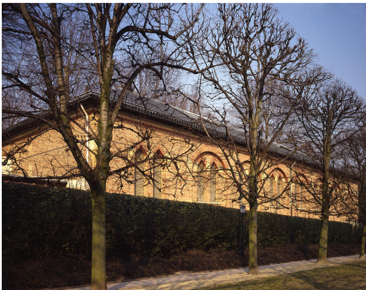
La gymnase. Façade latérale sur l'Allée d'Honneur du château.
