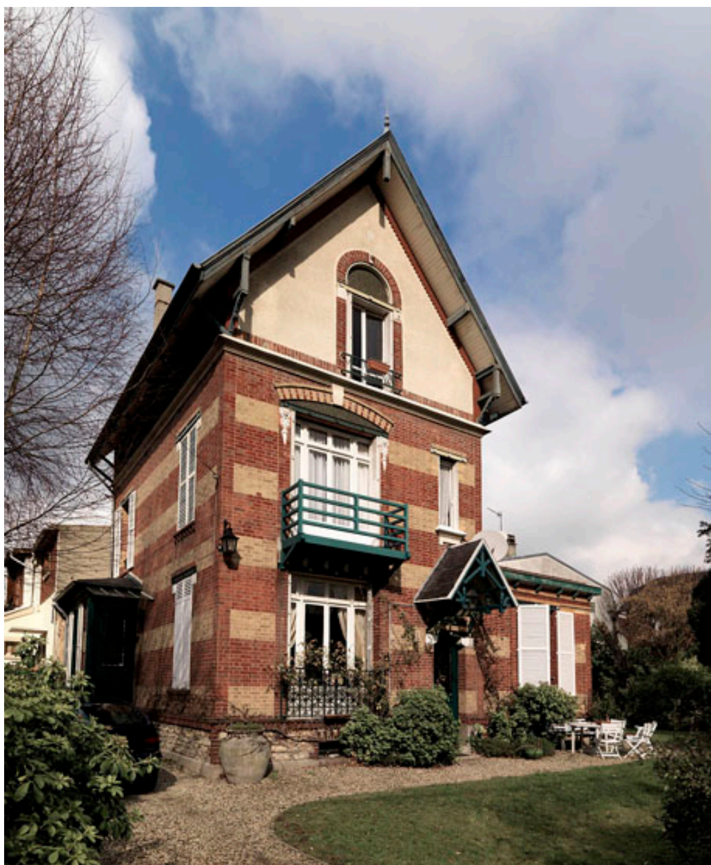
Maison n°4 Villa des Sureaux, vue d'ensemble.
