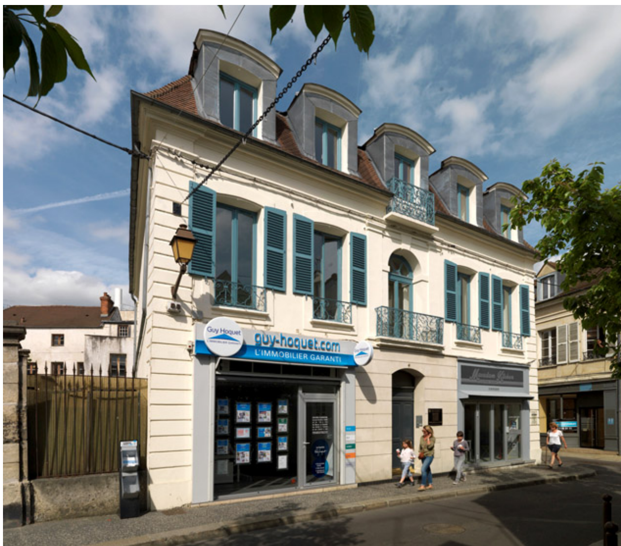
Hôtel, 4 rue Gambetta. Façade sur rue.
