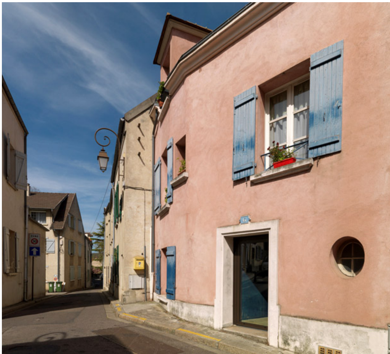
Maisons très transformées rue des Tanneries.
