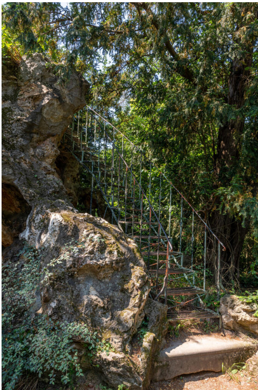
Grotte des quatre vents. Escalier d'accès au belvédère.
