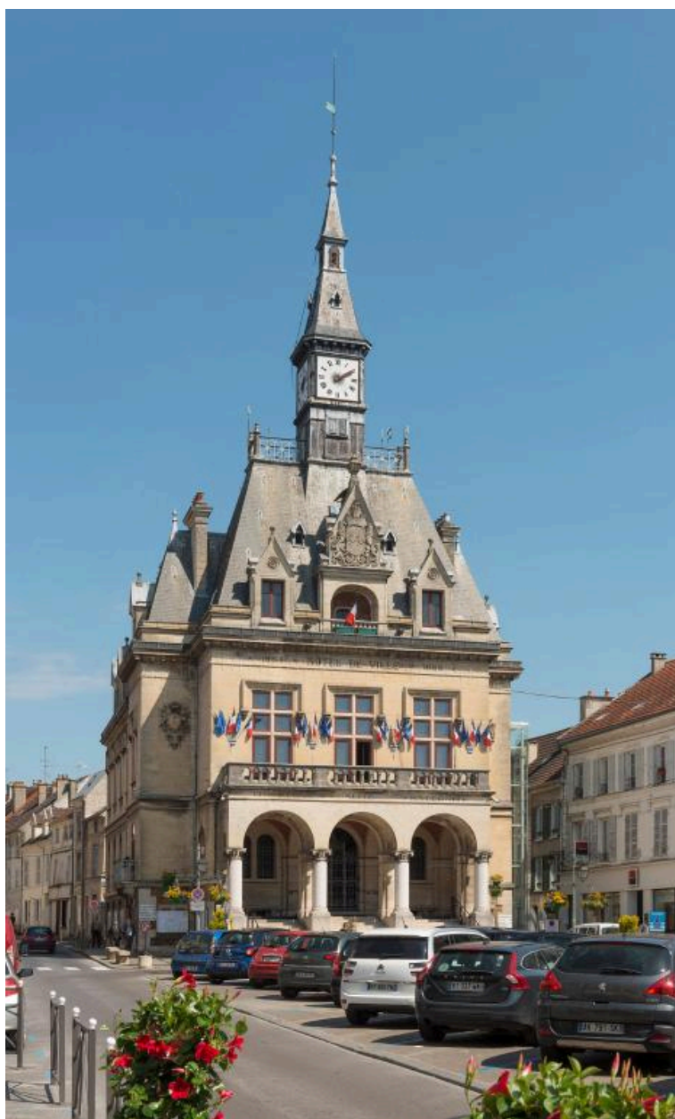
Vue d'ensemble : la façade occidentale et l'élévation latérale nord.
