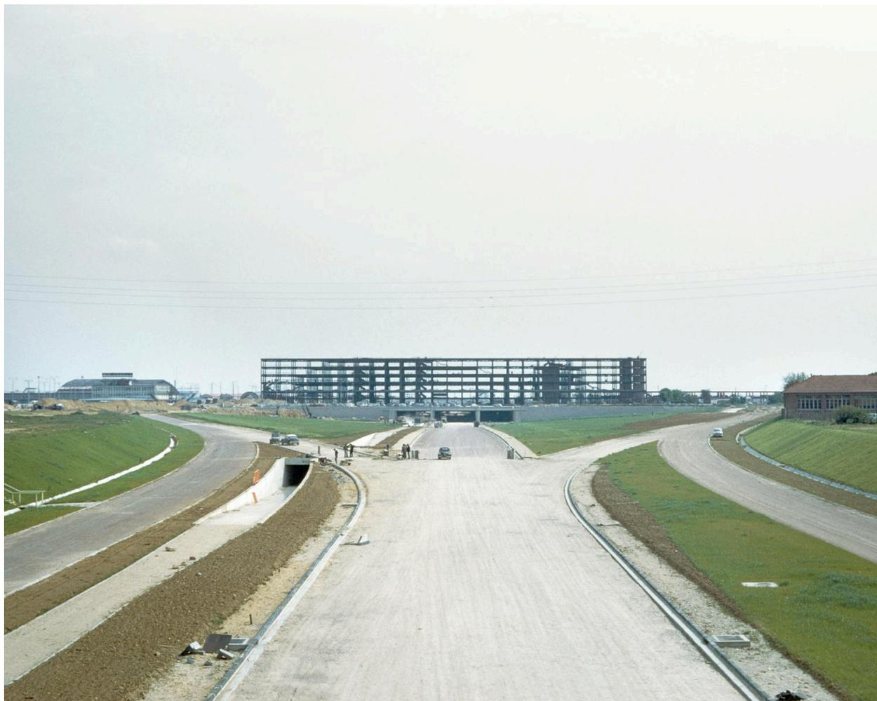
1957 1961, la construction des Installations Terminales, le montage de l'ossature métallique en 1958, vue prise depuis la tranchée de la Nationale 7 (nouveau tracé) en construction au nord.
