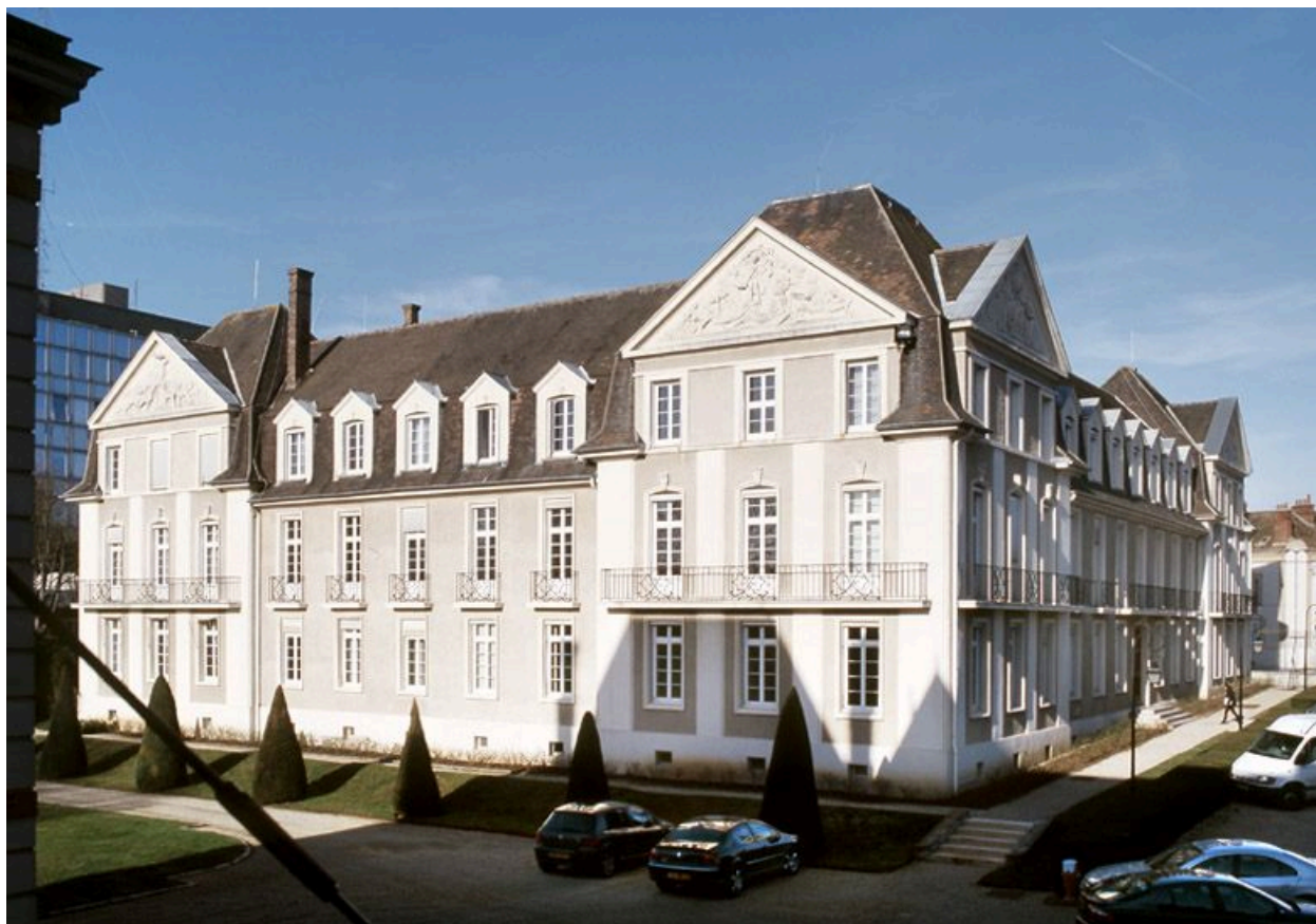
Le bâtiment des années 1950 : vue d'ensemble, depuis l'hôtel de la préfecture.
