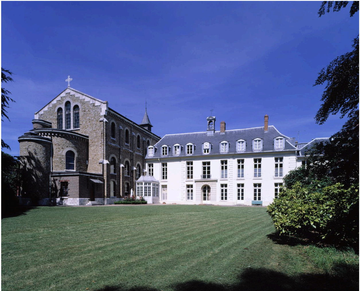
Autre vue de la façade postérieure.
