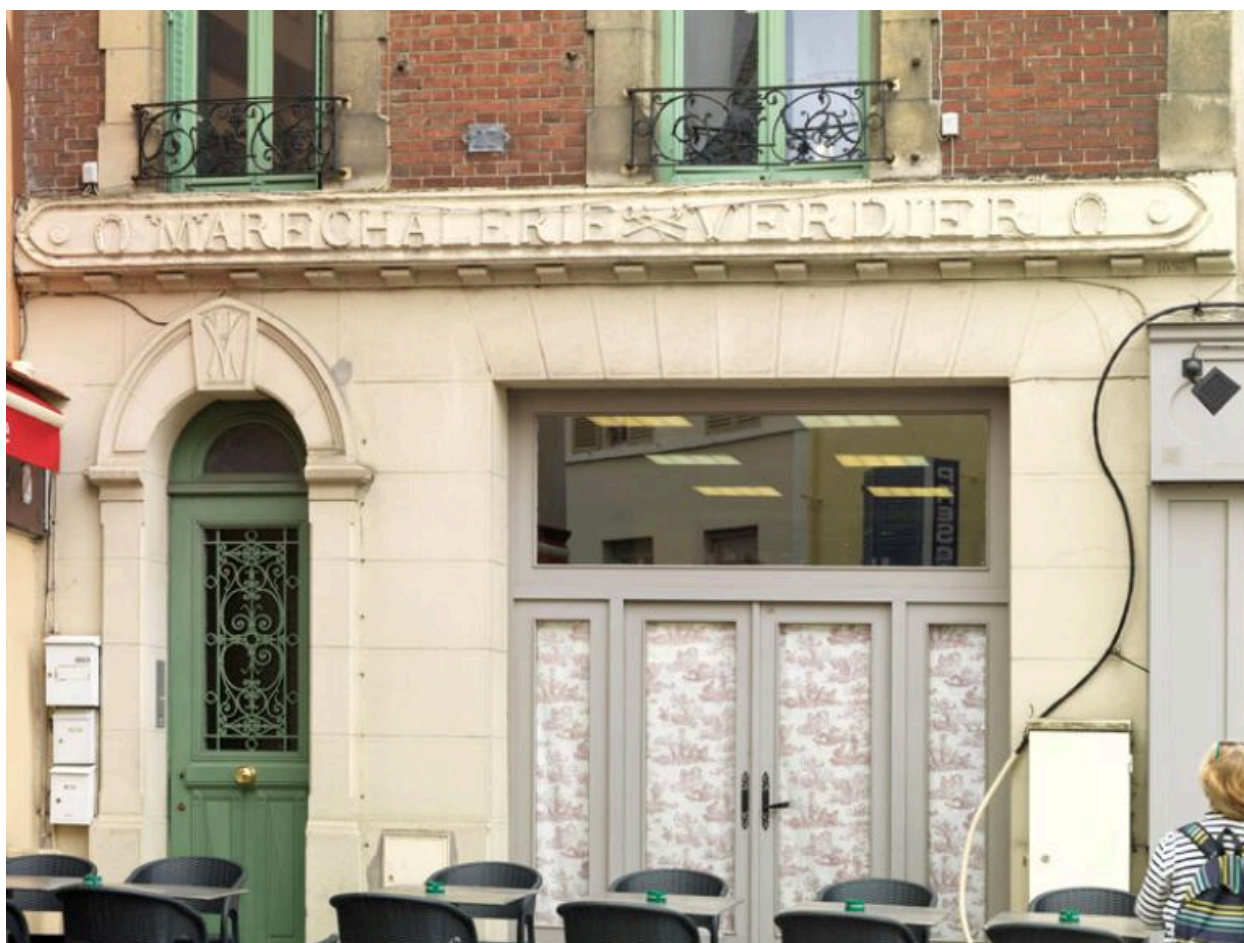
Maison de bourg, 23, place du Marché au blé. Détail de la boutique avec le bandeau publicitaire et les outils du maréchal ferrant.
