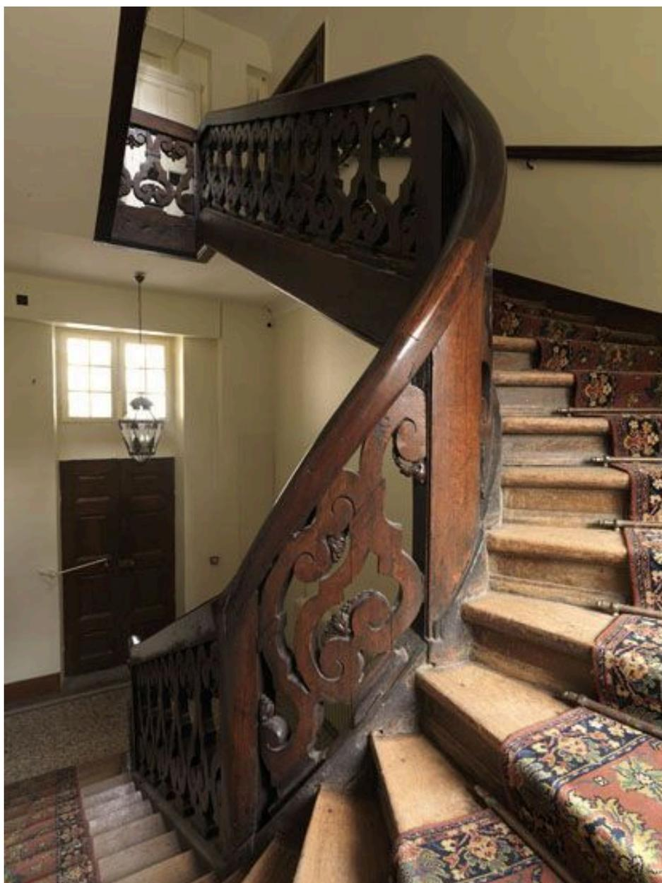
Balustre et demi-balustre dans la partie tournante.
