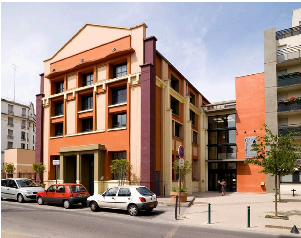
Choisy-le-Roi, ancienne tannerie, transformée en conservatoire de musique, 12 bis rue du Docteur-Roux. Vue de l'entrée.
