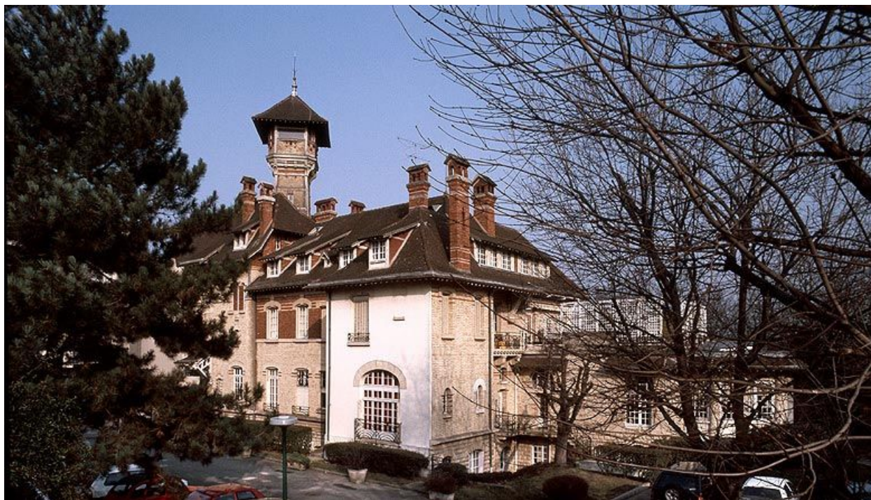
L'angle nord ouest de la demeure.
