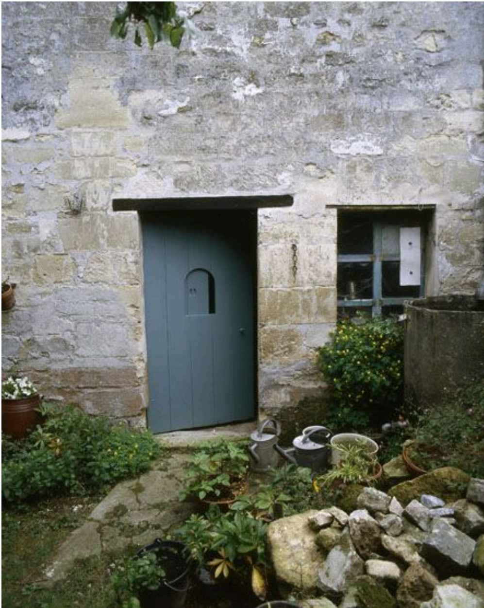
Le bâtiment d'exploitation agricole entre cour et jardin : la porte desservant l'ancienne chèvrerie.
