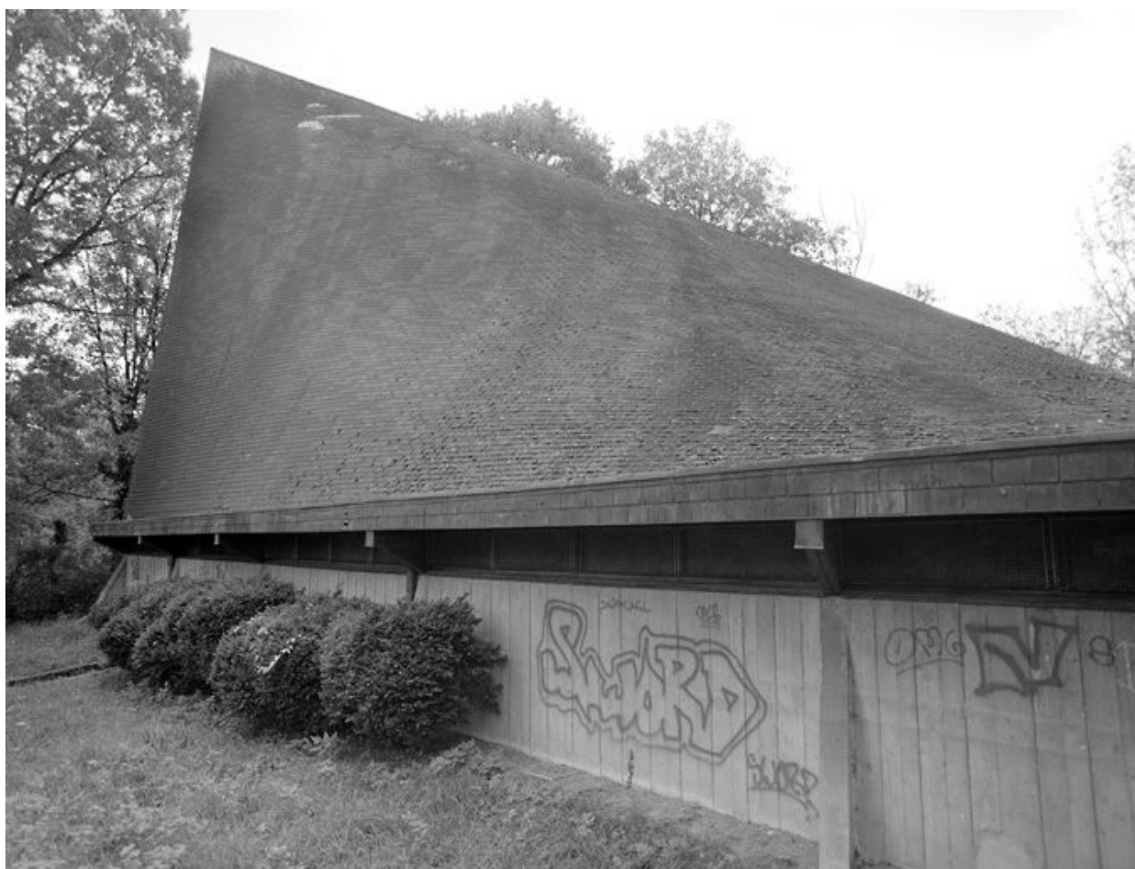
Vue de la façade nord.
