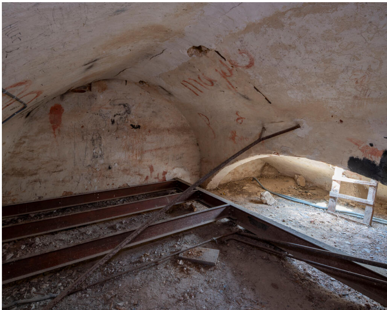
Charpente en maçonnerie de moellon et brique.
