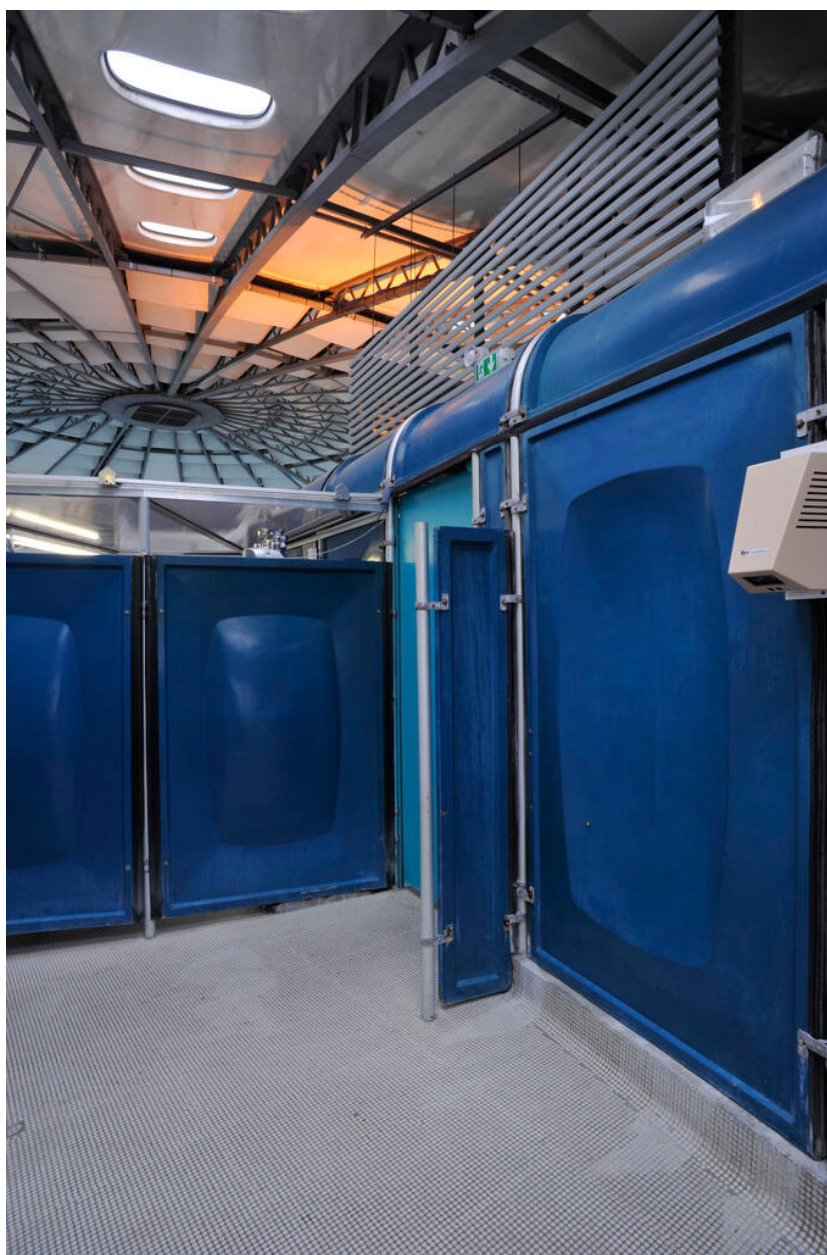
Détail intérieur : vestiaires. Piscine tournesol de la Cavée
