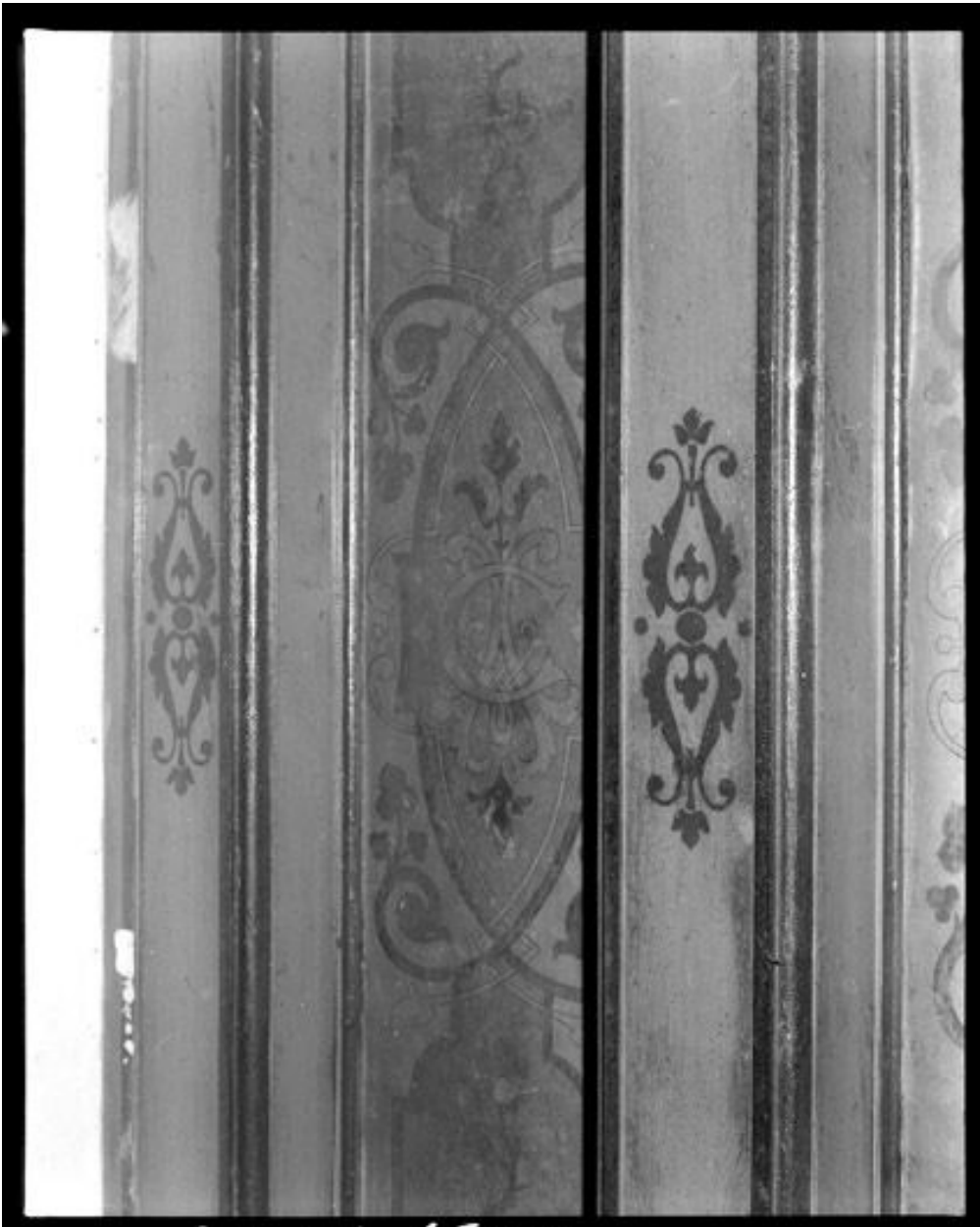
Détail d'un plafond à la française. Etat en 1977.
