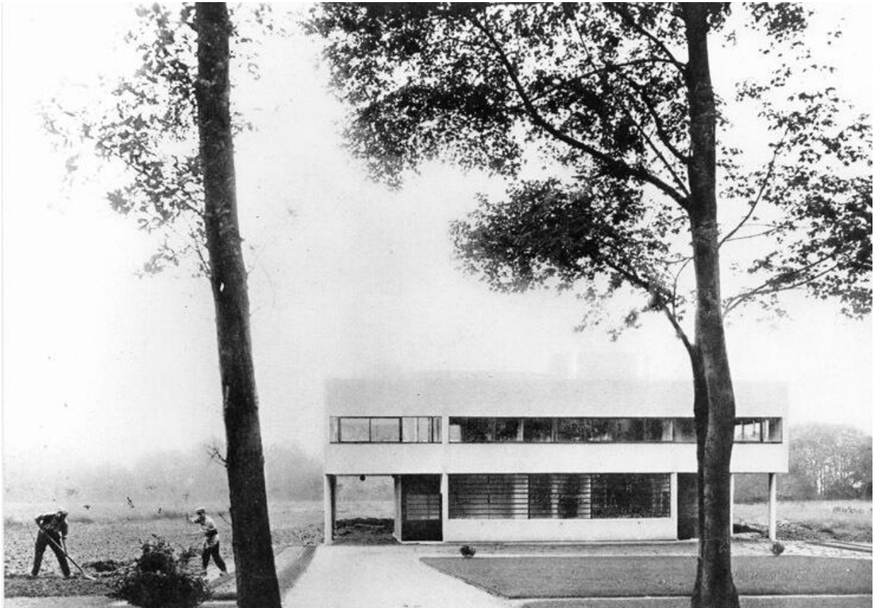
Vue de la façade méridionale. Photographie. Tiré de : L'Architecte, 1930. (Domaine départemental de Sceaux).
