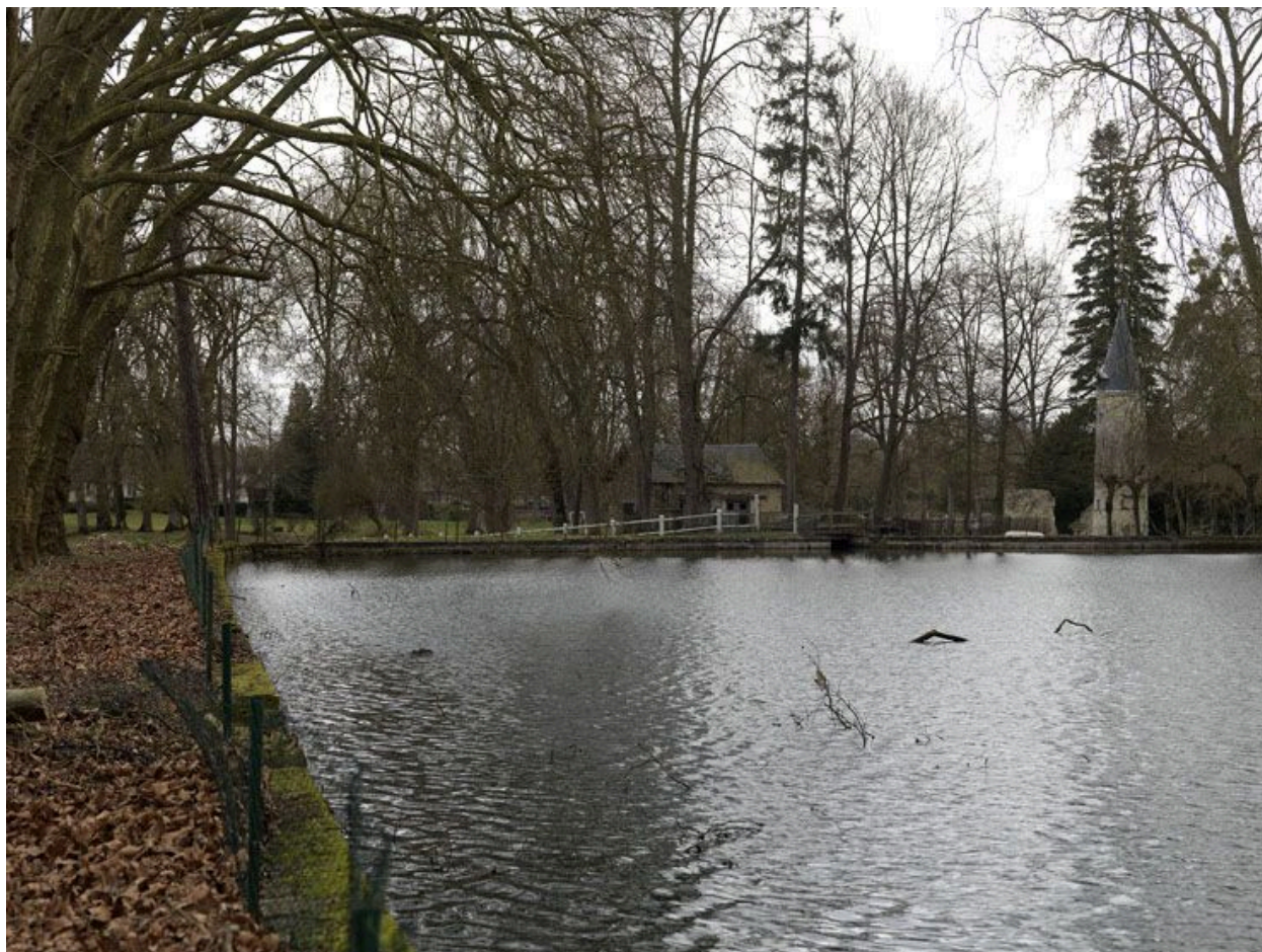
Vue générale du bassin de retenue, depuis le sud-est.
