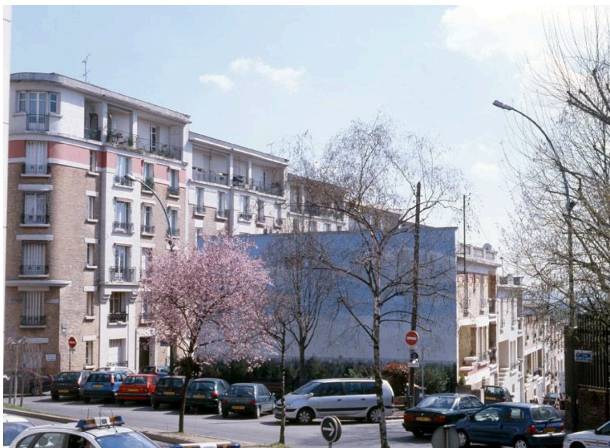
Vue d'ensemble du lotissement de 1930 réalisé par les architectes Bauve et Schwallier, square de la Fontaine.
