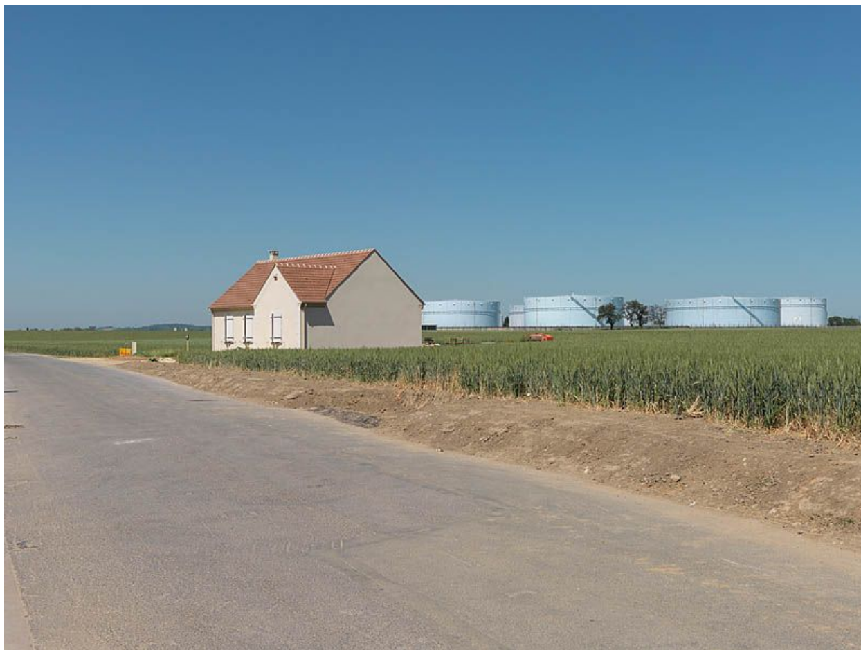
95, Épiiais-lès-Louvres. Vue générale à l'ouest de la commune. Au fond, les réservoirs d'hydrocarbure.
