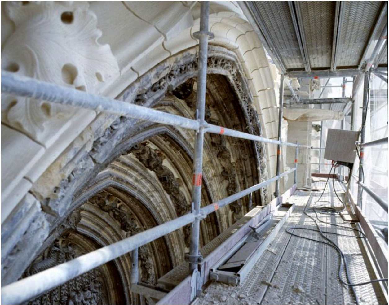
La façade occidentale : vue du chantier de restauration de la base de la tour nord (2008). Détail de l'échafaudage, au sommet du portail Saint-Jean-Baptiste (vue prise depuis le nord).
