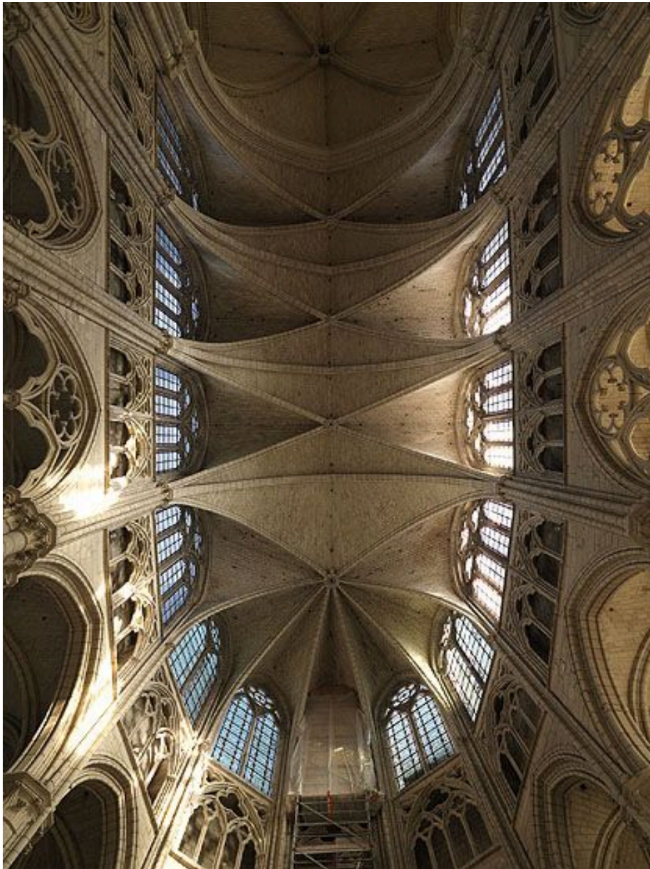
Les voûtes du vaisseau central du choeur et de l'abside.
