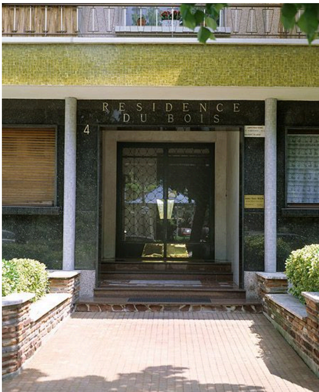
Immeuble dite résidence du bois, 4 place Pierre Sépard. Détail de l'accès à l'immeuble.
