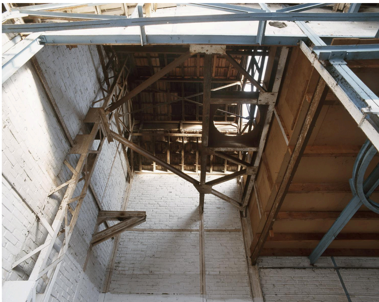
Support de l'ancienne cheminée métallique, au dessus de l'emplacement des fours.
