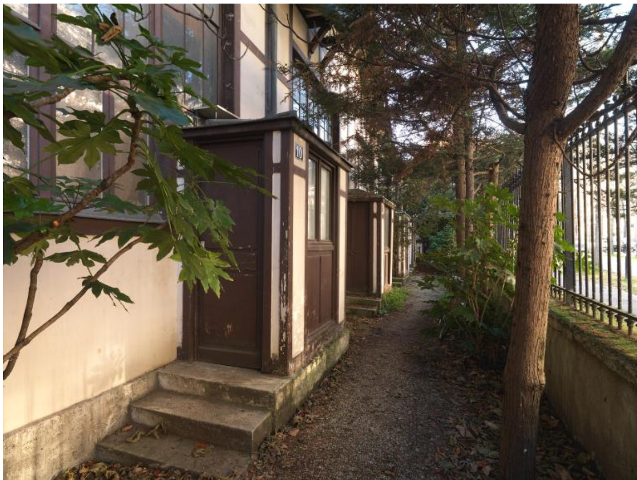
Vue de la façade des ateliers, côté boulevard Arago
