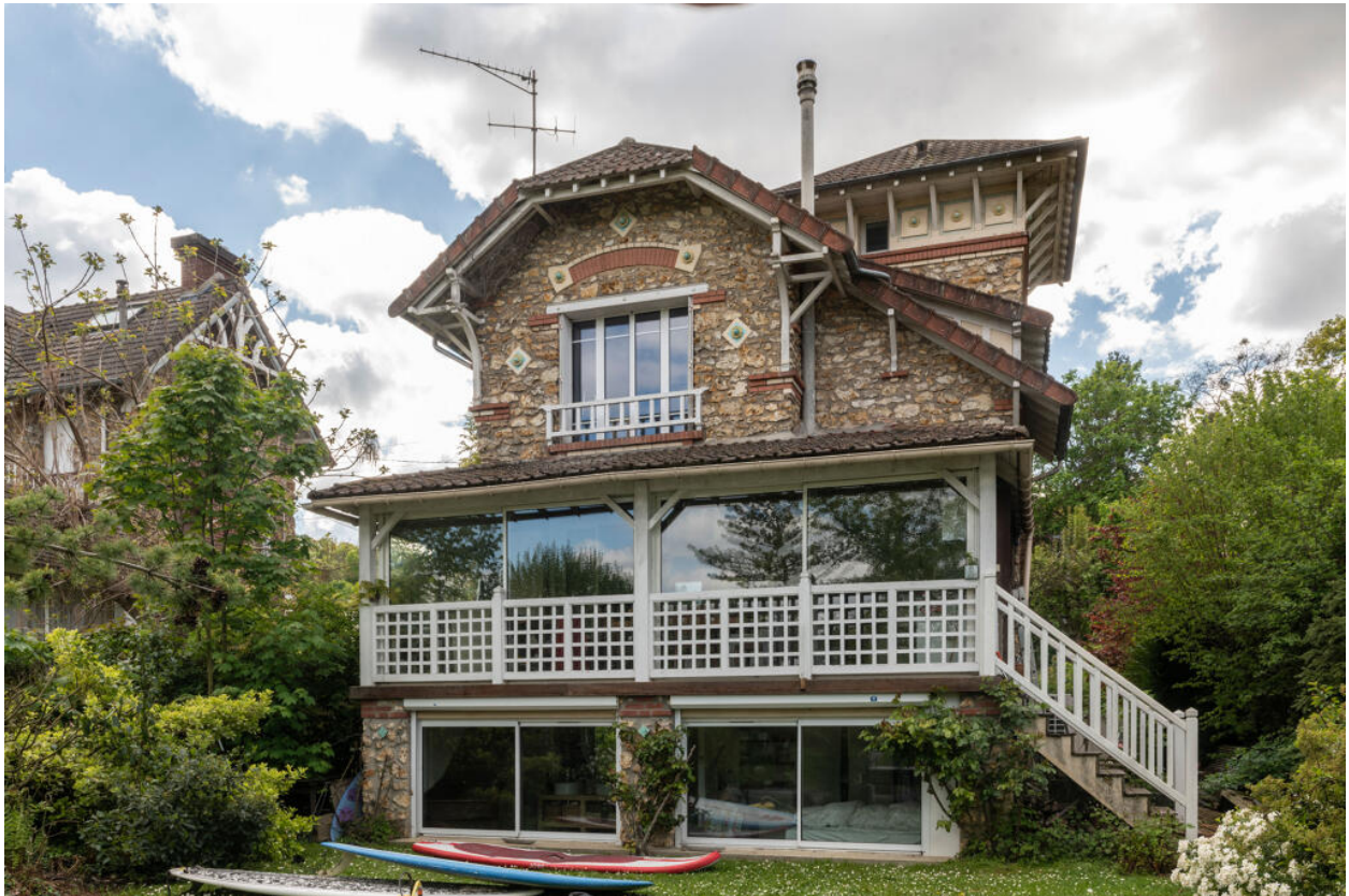
Façade postérieure, face à la Seine, modifiée par une extension.
