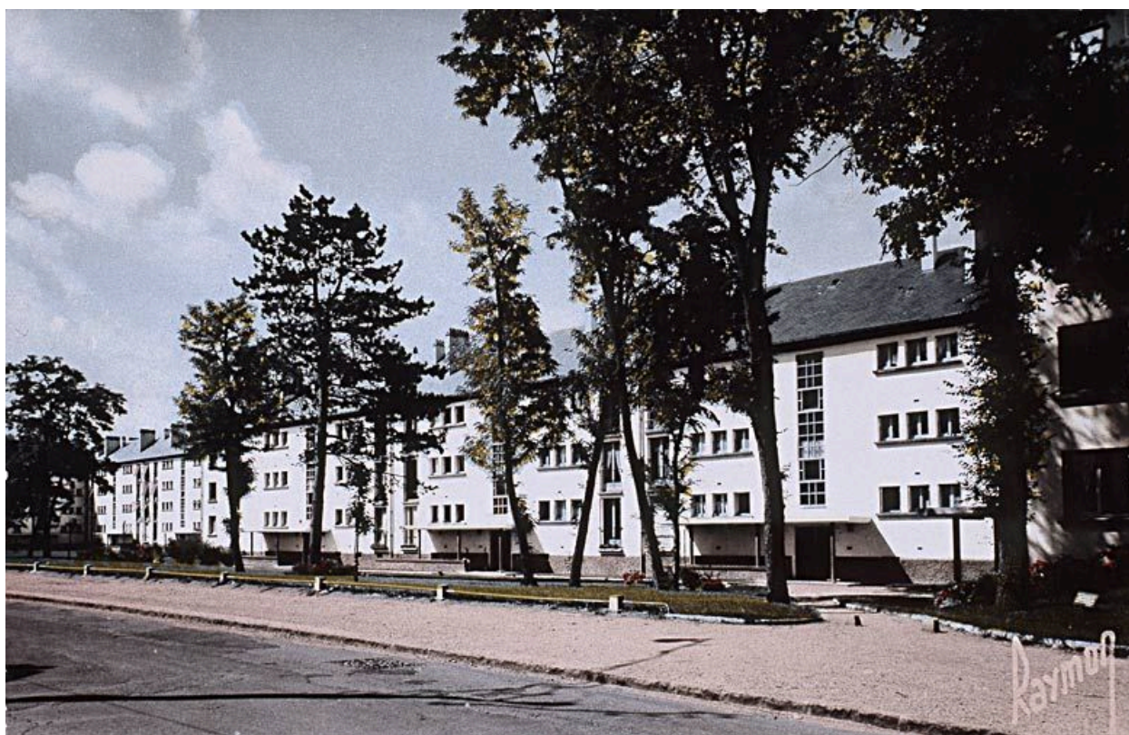
Vue de l'un des immeubles en bordure du boulevard Henri-Barbusse. Carte postale, vers 1960. (AD Essonne, 2 Fi 63)
