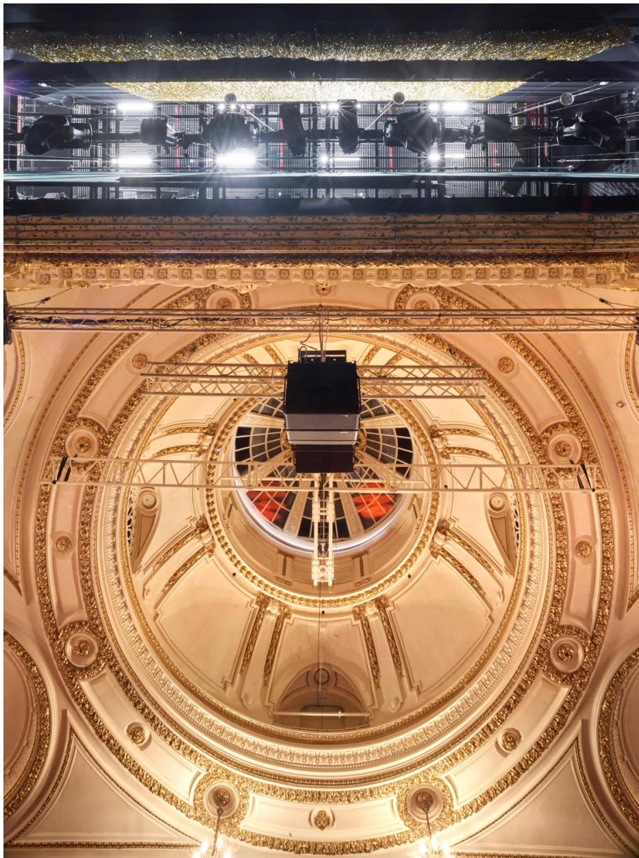
Coupole et verrière zénithale
