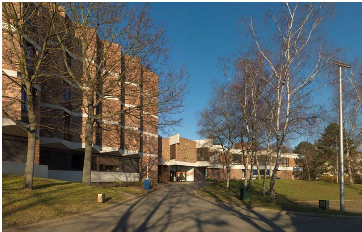
Vue d'ensemble de la façade d'entrée.
