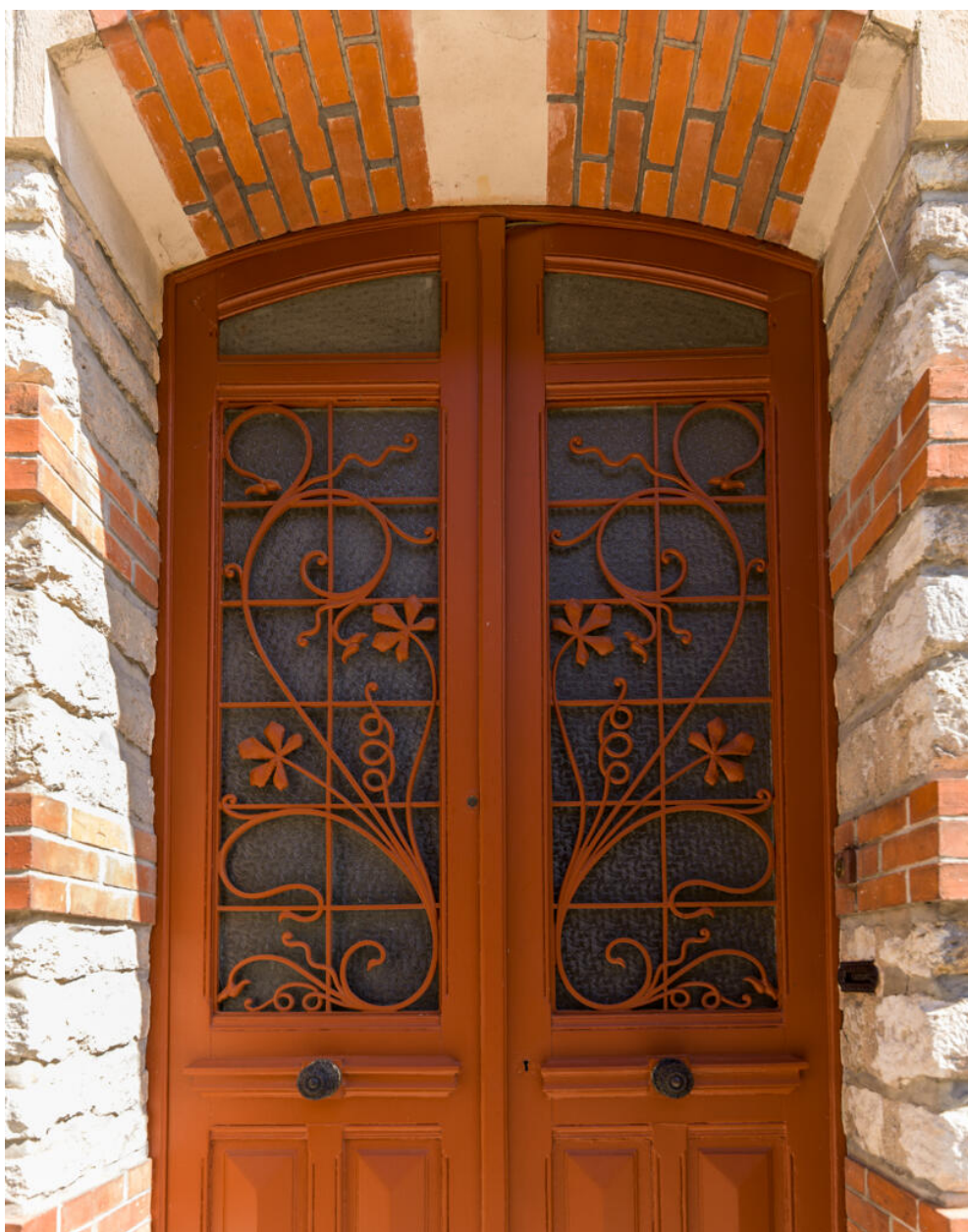
Détail de la porte d'entrée située rue Langlois.
