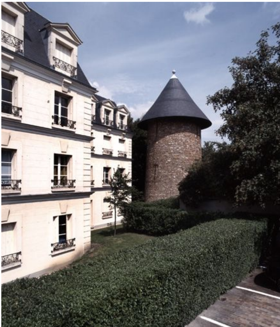
Le château d'eau couvert d'un toit en poivrière, à côté du nouveau corps de bâtiment.
