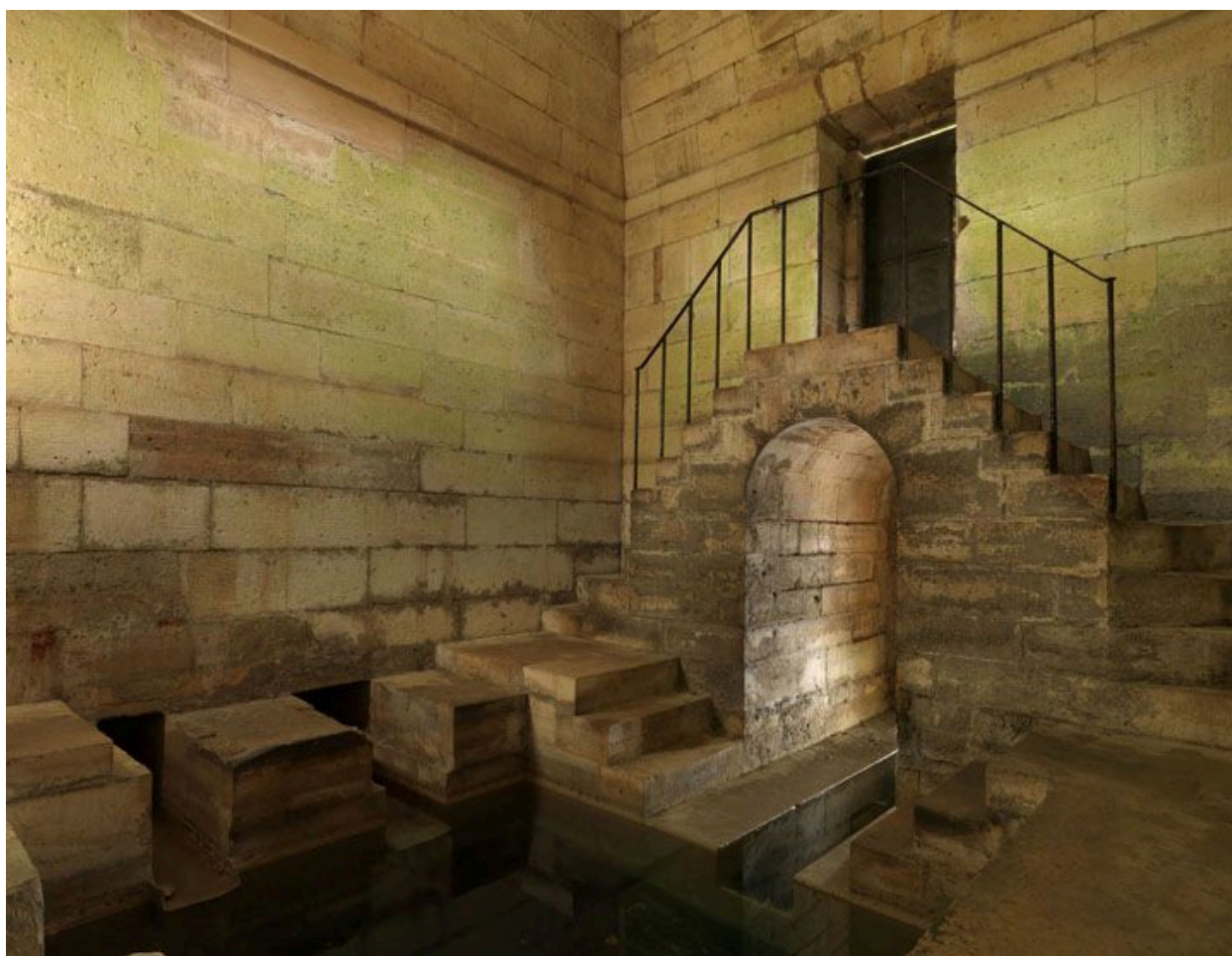
Rungis, Ecoliers (passage des). Vue de l'intérieur du regard I : Escalier interne, bassin avec rigoles et galerie.
