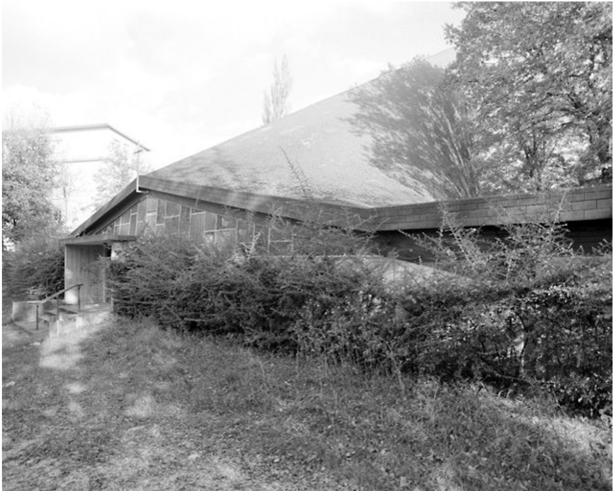
Vue de la chapelle côté sud.
