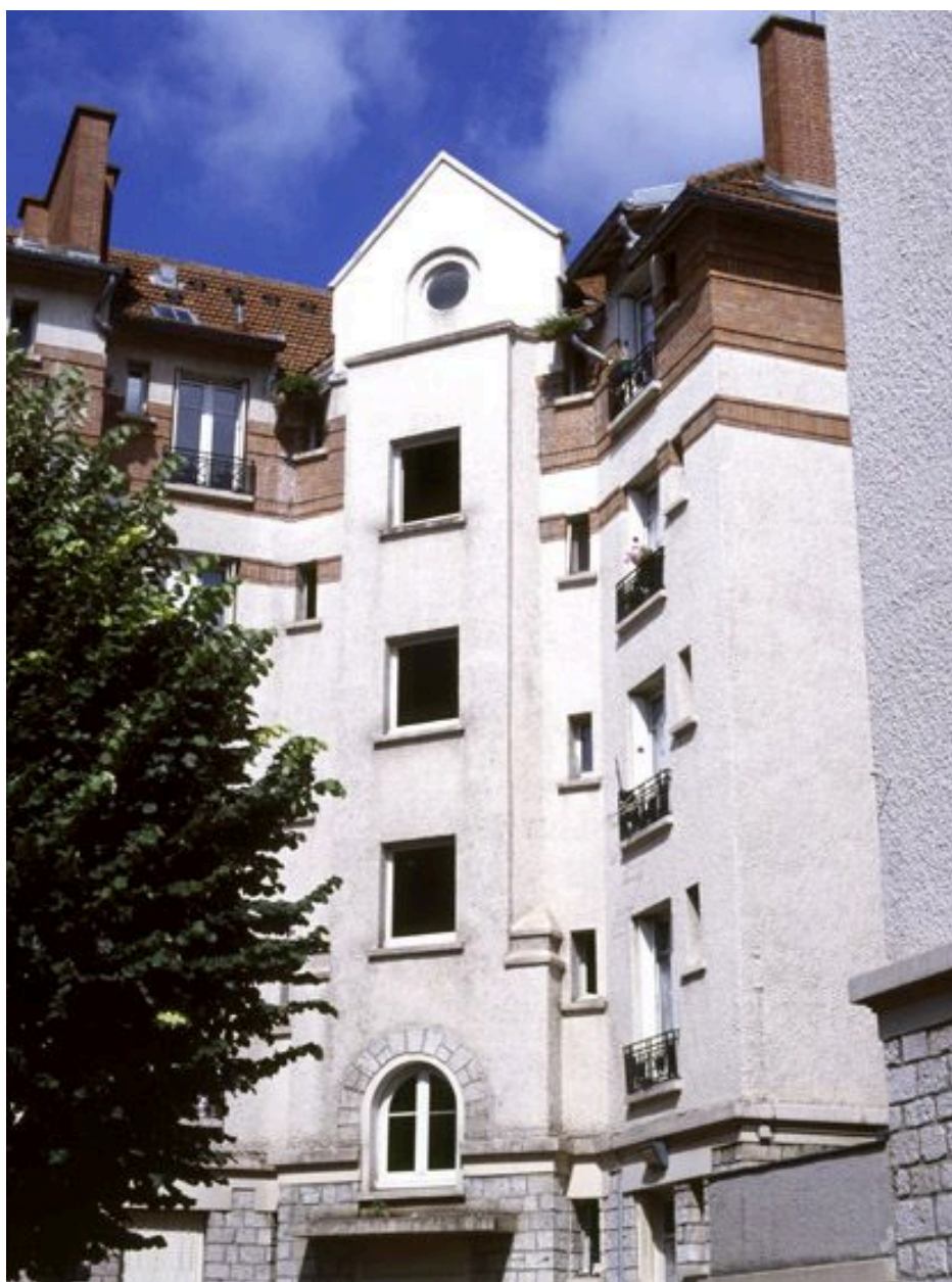
Détail d'un immeuble, avenue de la République.
