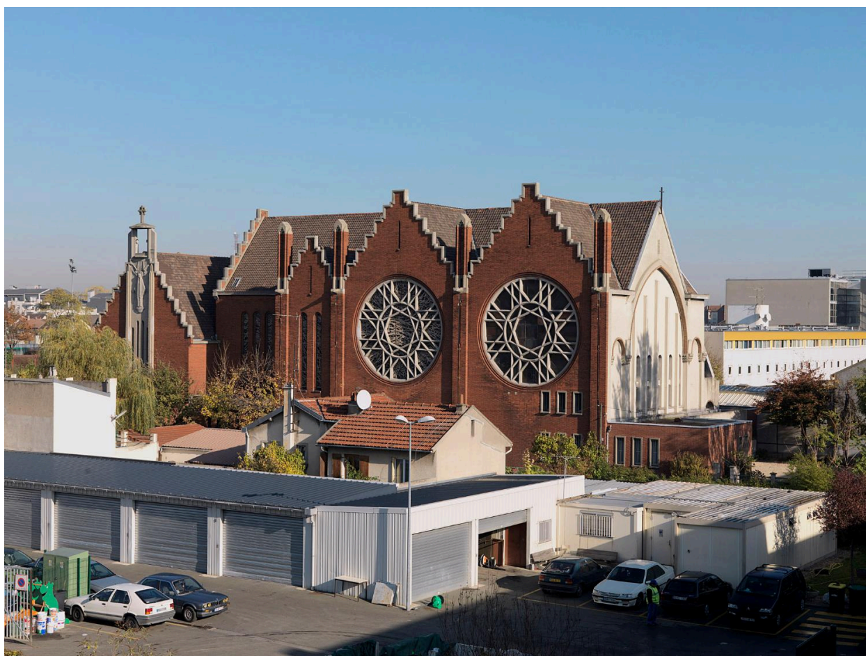
Vue actuelle de la façade Sud.
