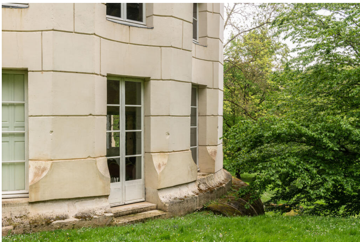
Détail d'une porte-fenêtre côté nord.
