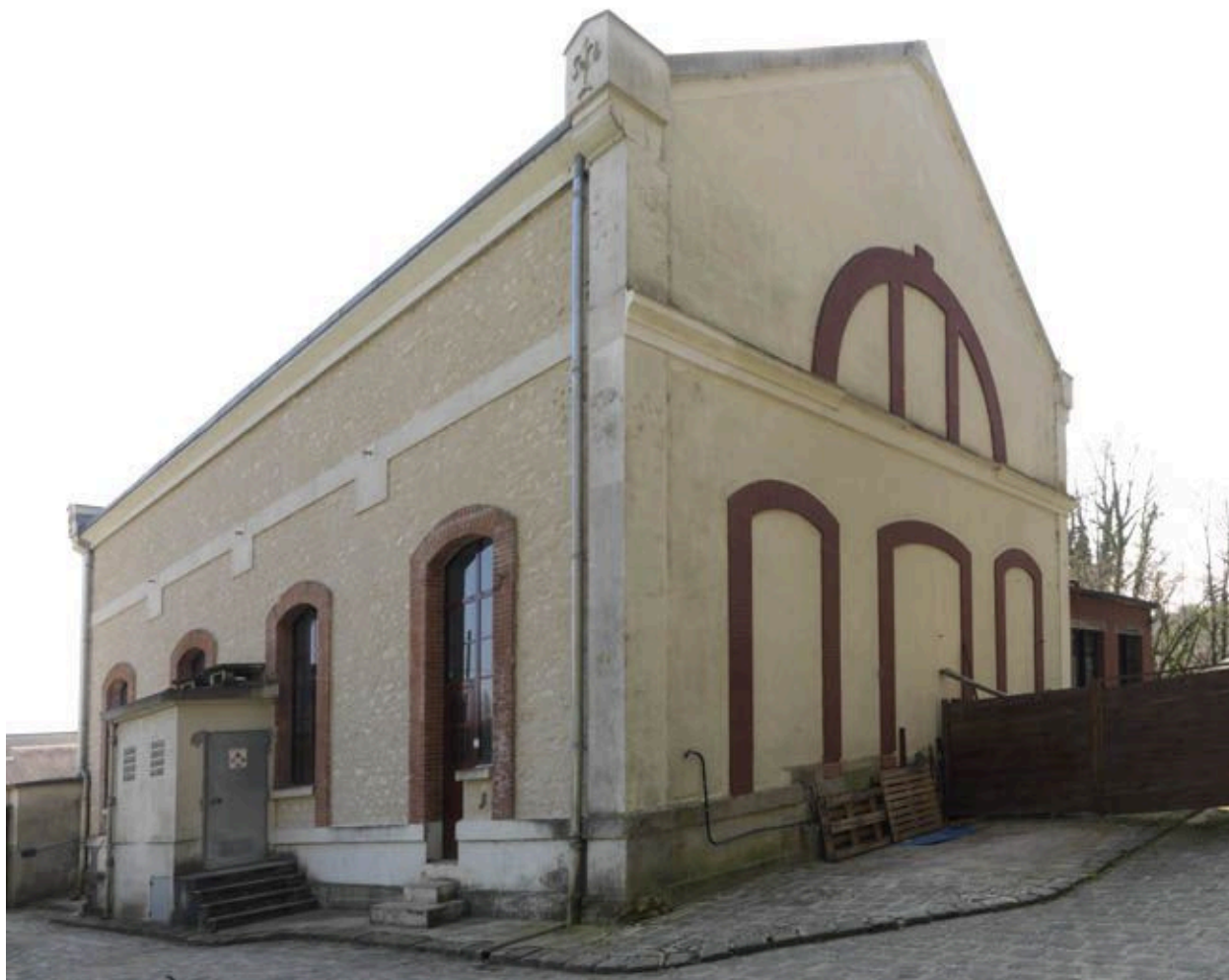
Bâtiment des pompes, depuis le nord-ouest.
