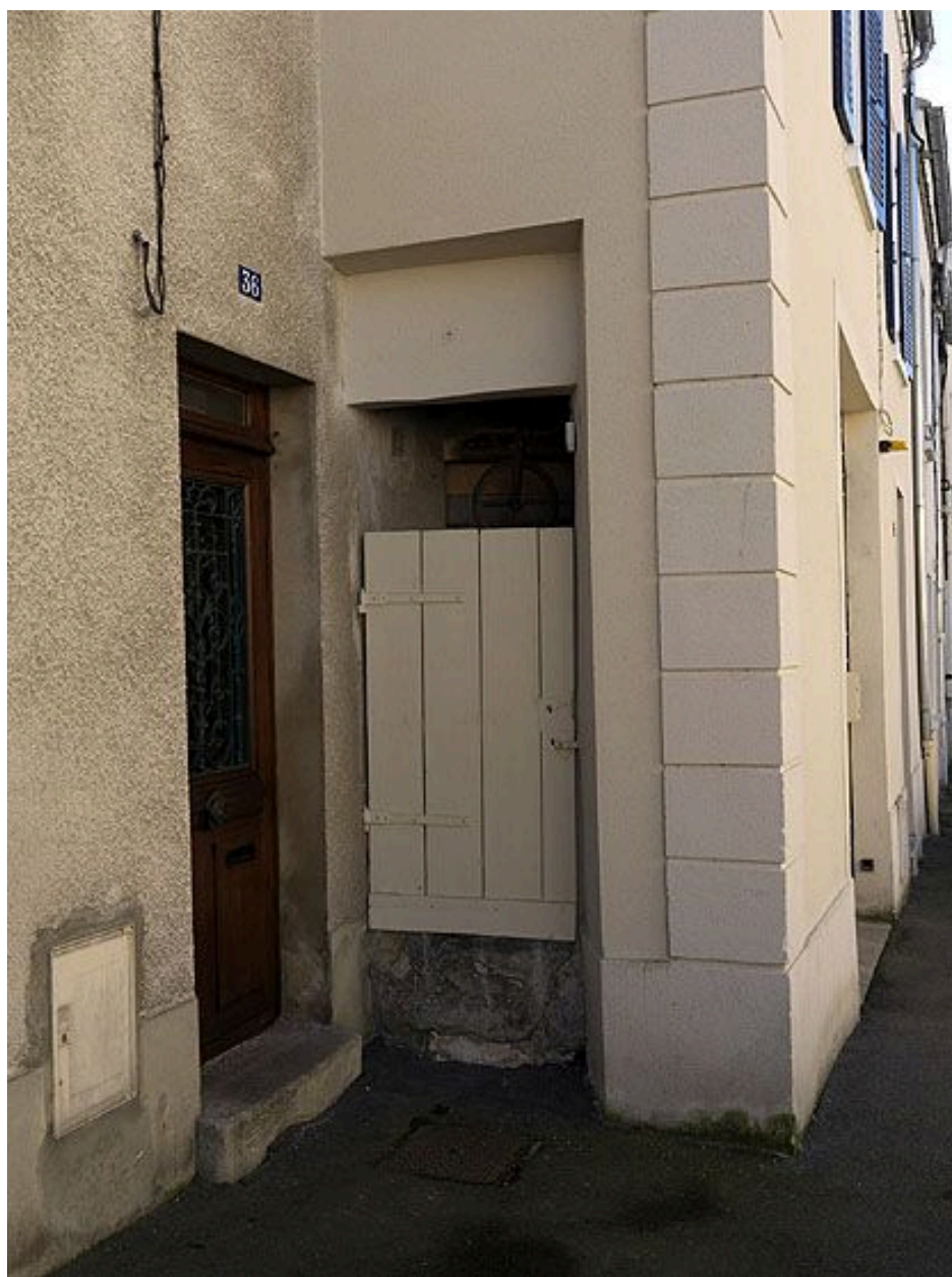
Puits couvert, à l'angle des n°32 et 36 de la rue Croix-Saint-Loup.
