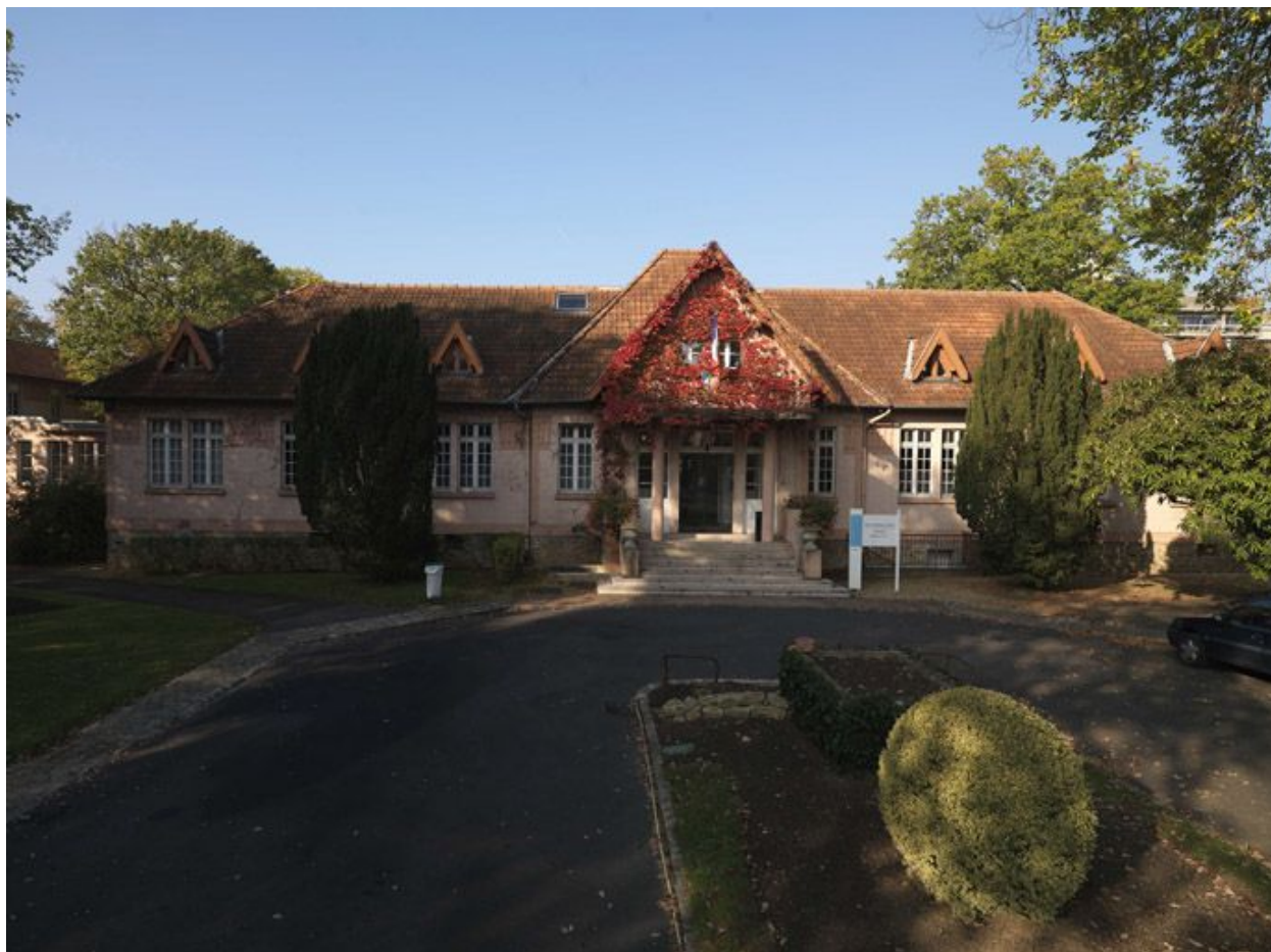
Vue du bâtiment d'entrée.
