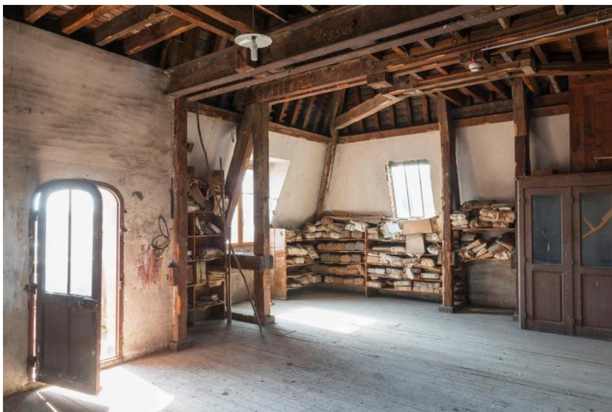
Les combles, avec à gauche, la porte donnant vers la loggia.
