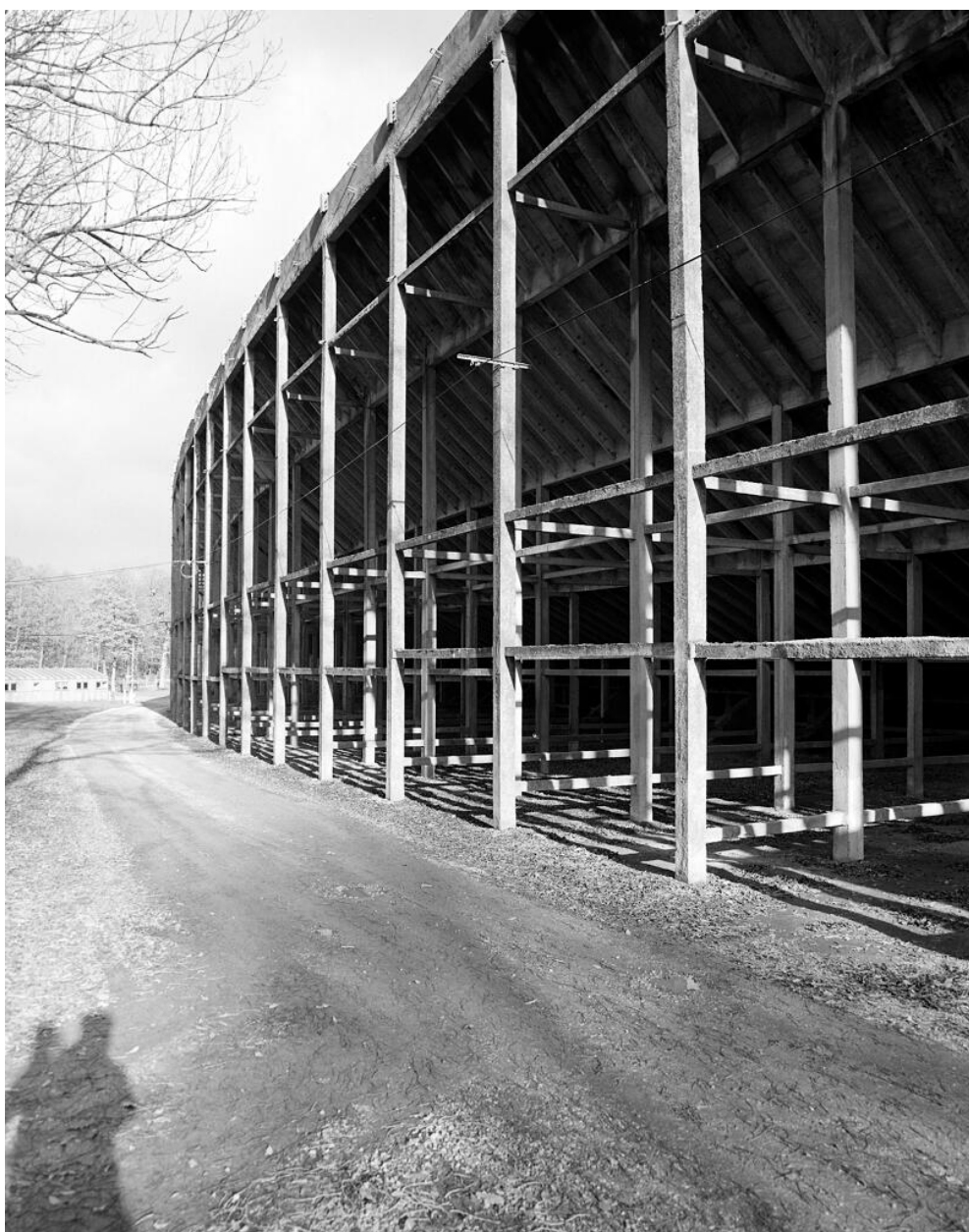
Détail de la structure du sous-bassement de l'anneau de vitesse. Autodrome
