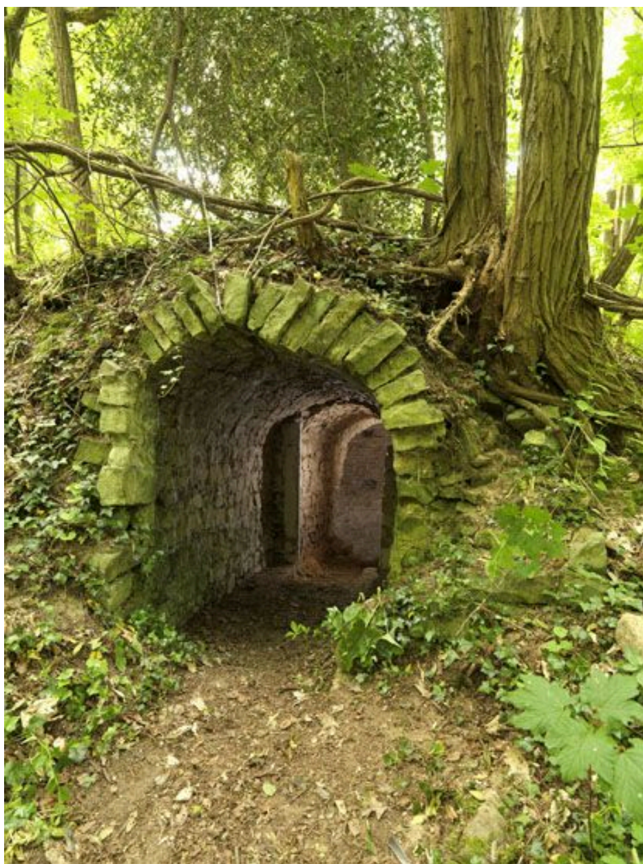
L'entrée et le couloir de la glacière.
