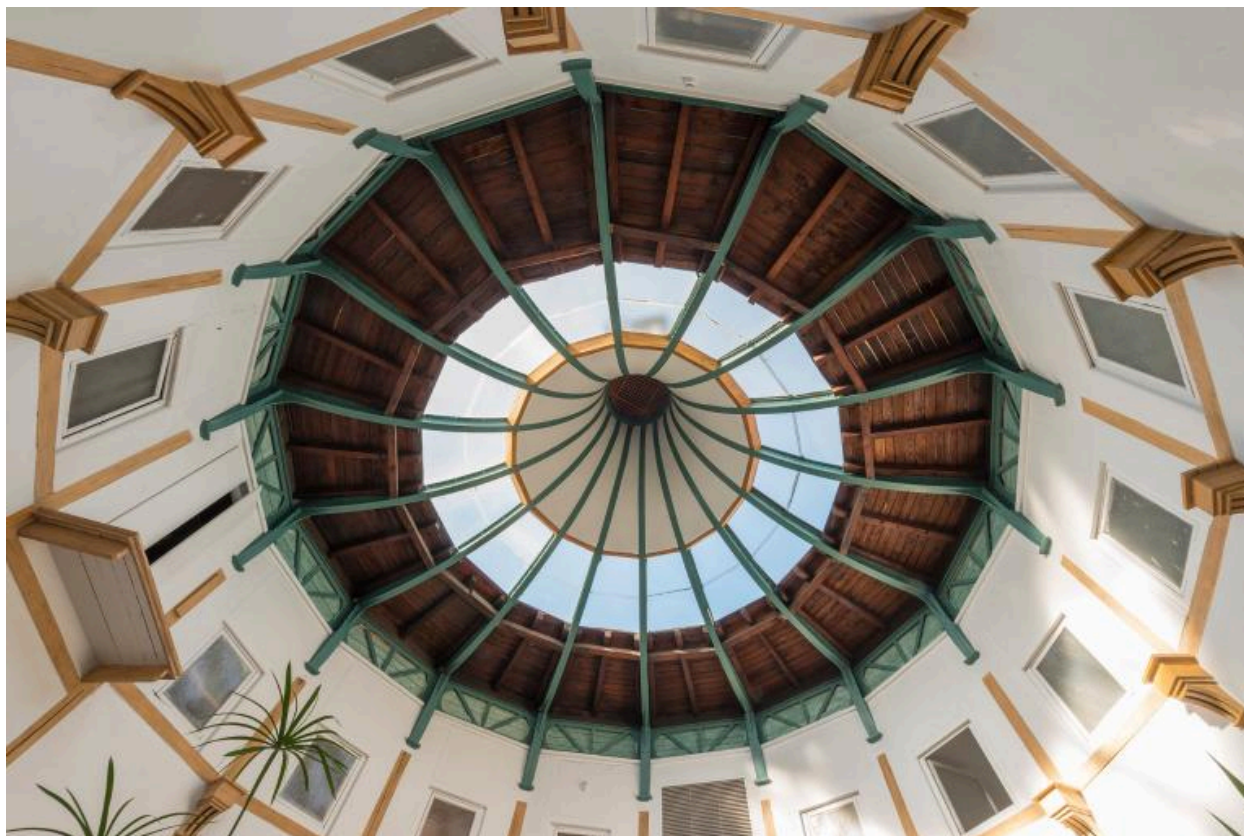
Vue de la charpente métallique de la Rotonde (2)
